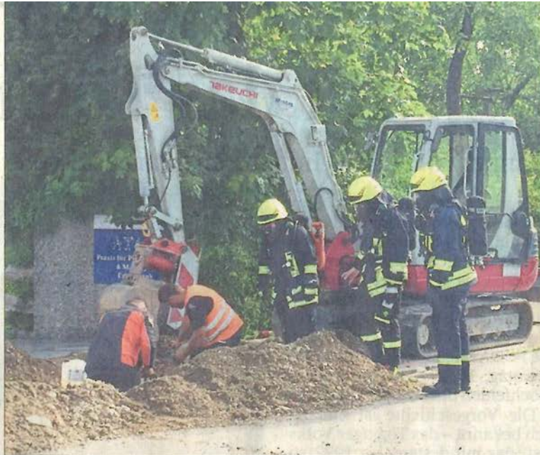
Drei Feuerwehrmänner mit Atemschutzmasken beobachten, wie die Bauarbeiter sich bemühen, das Leck in der Gasleitung zu finden und abzudichten. – Foto: timebreak 21
